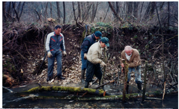
Renaturation biologique de la berge dans les marais de St Thibaud. Piquets de saules et fascines. Mars 1997.
