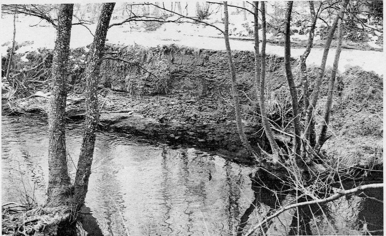
Vue de la berge effondrée avant travaux
