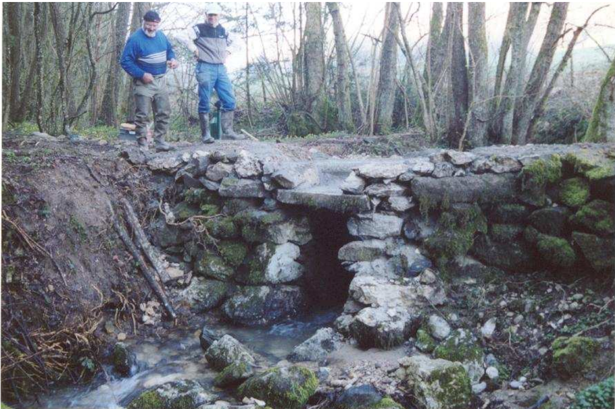
La Gaule des Coudans. Les chantiers sur l'Hyères.
