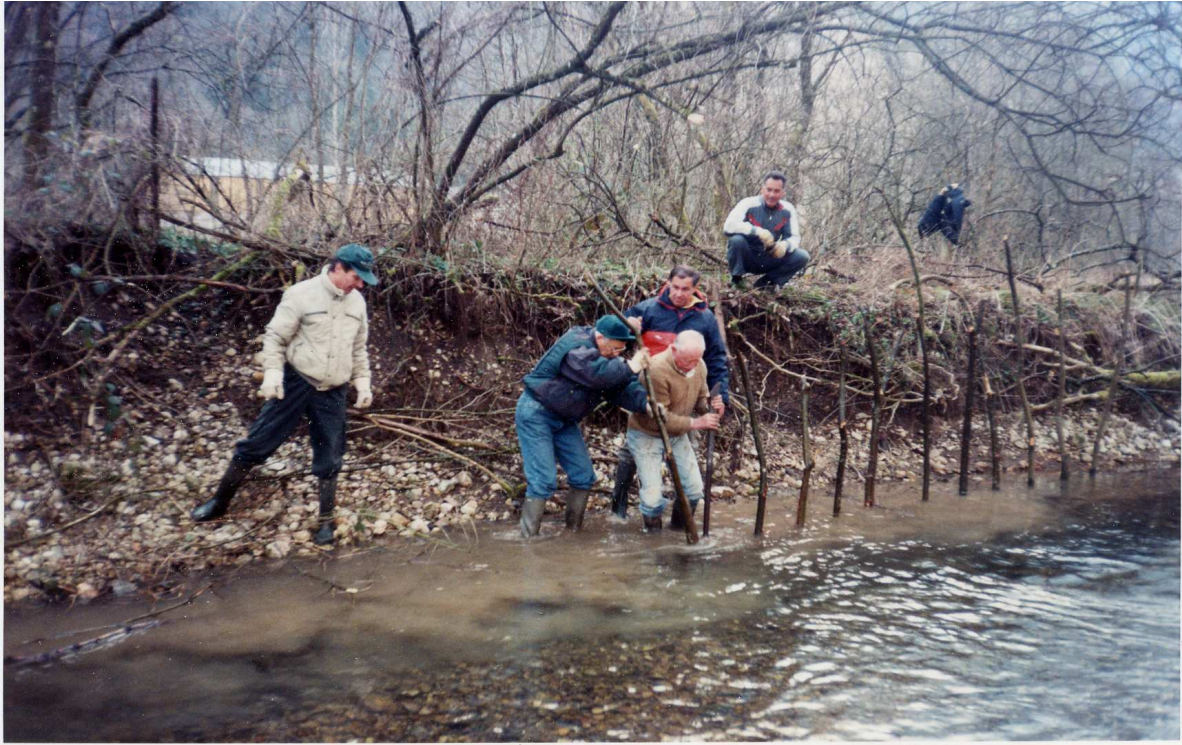
Renaturation biologique de la berge dans les marais de St Thibaud. Piquets de saules et fascines. Mars 1997.
